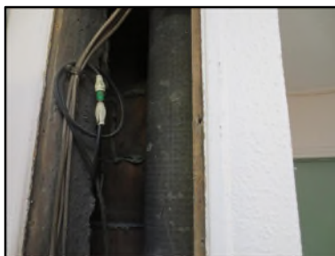
Photo N° 645 AMIANTE CIMENT -- GAINE TECHNIQUE eau usé - RDC Gaines & coffres verticaux Chute E.U. (Fibres-ciment)
